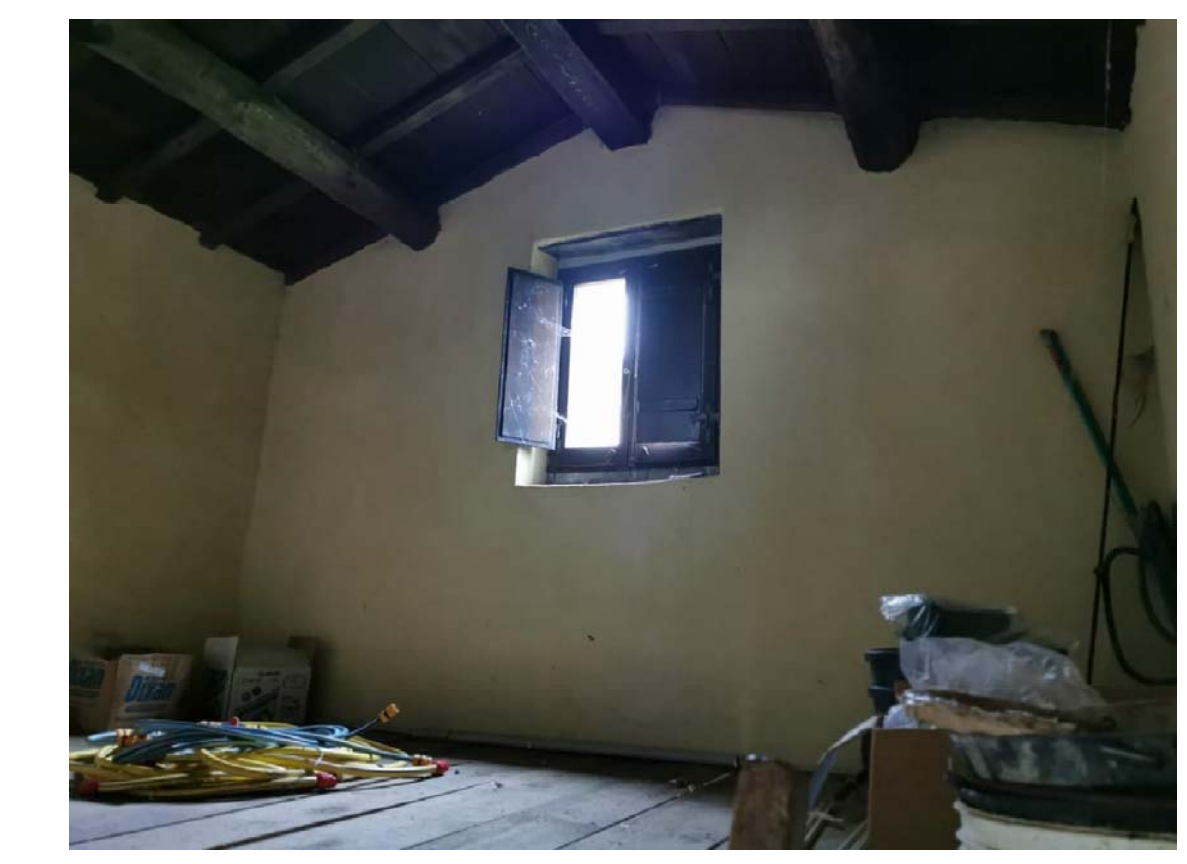
12 Fotografie interno gabbiotto piano primo
